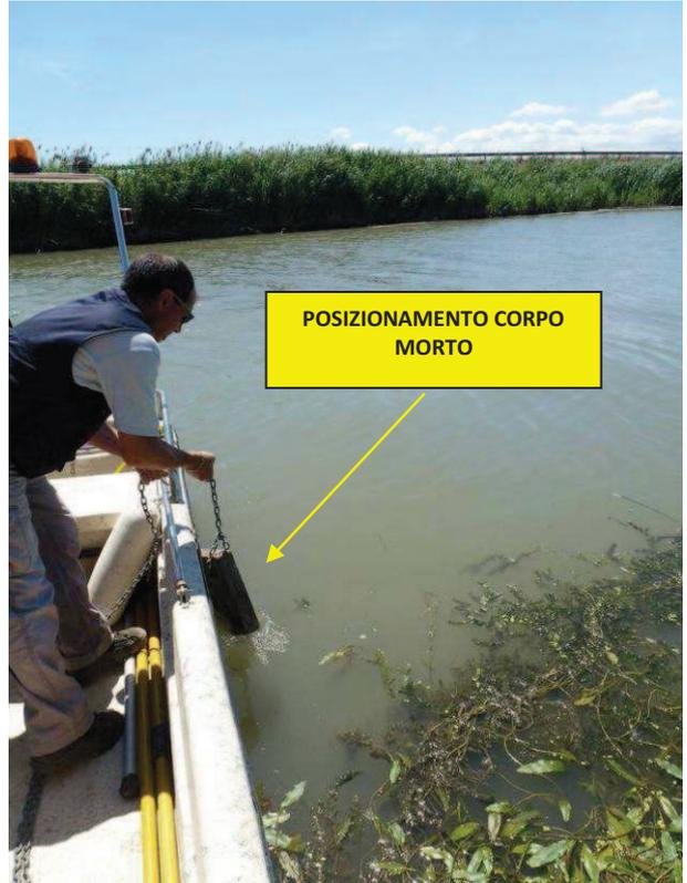
Fig.15. Posizionamento corpo morto su fiume Gorzone, Cavarzere (VE)
