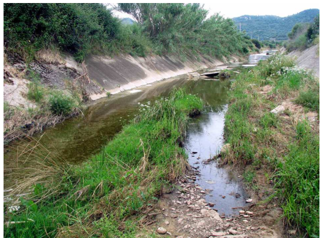
Fig. 8 – Canale Monte Depuratore (Sardegna).
