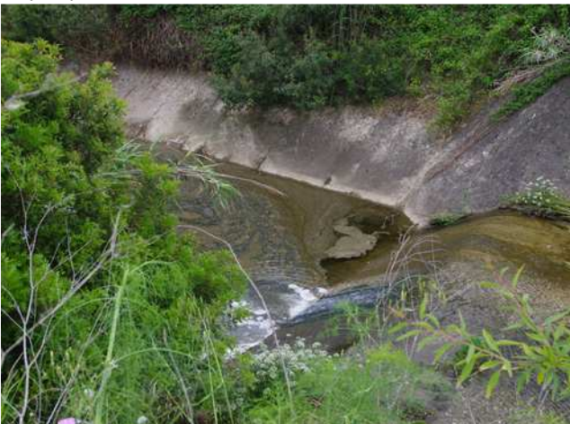
Lotic habitats - Canale Monte Depuratore, 22/05/2011.
