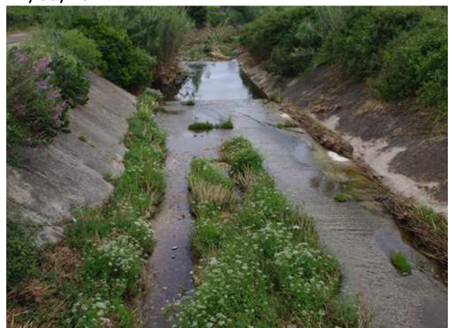
Special features/ Artificial channel - Canale Monte Depuratore, 22/05/2011.
