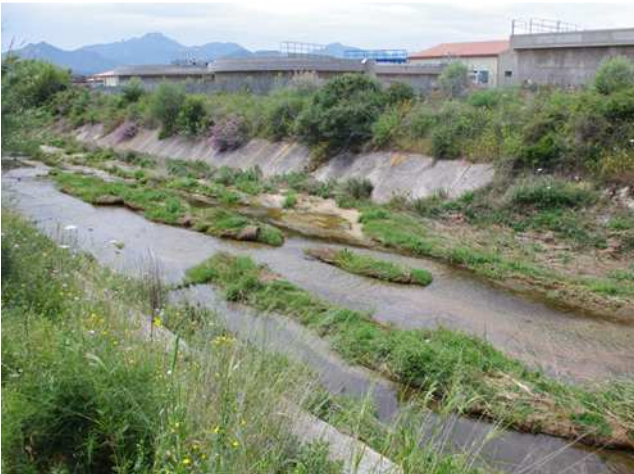
Site view/Channel – Canale Monte Depuratore, 22/05/2011.
