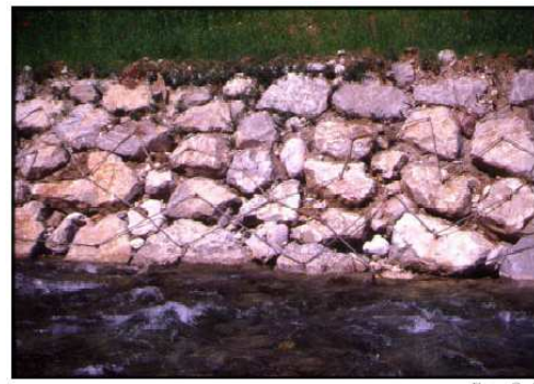
Corrazzatura in massi con funi di acciaio
