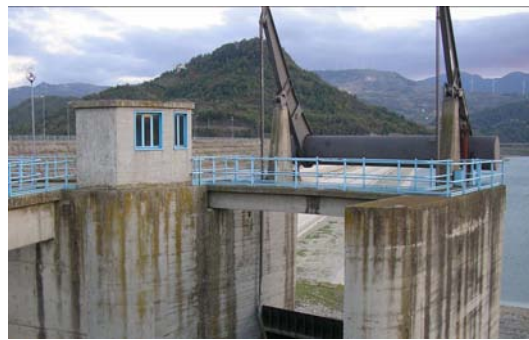
Particolare di scarico laterale con paratoia a ventola
