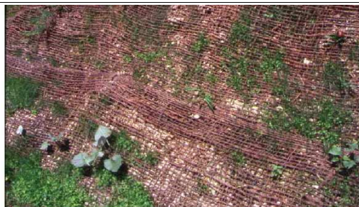
Rivestimento antierosivo in stuoia di juta
