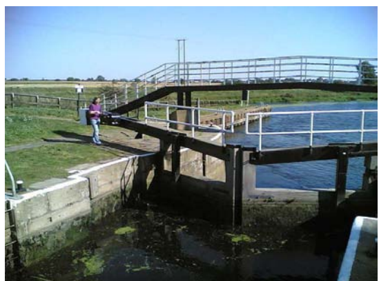
Chiusure sui canali navigabili
