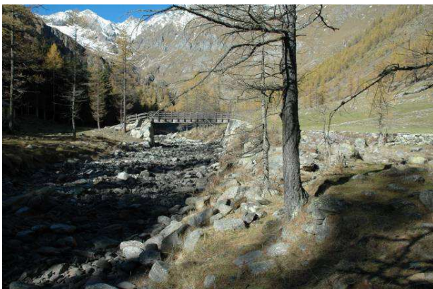
Vista verso monte del T. Campiglia al termine del tratto
