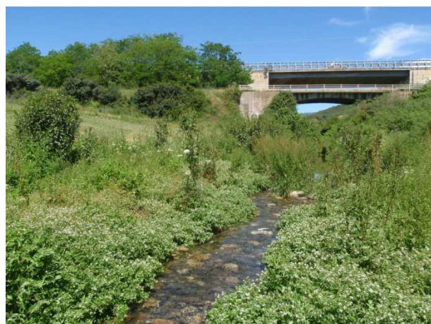
Ponte. Alveo e sponde risezionati.
