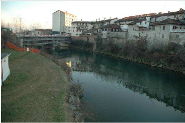
Il Ceronda in corrispondenza dell'abitato di Venaria. Dietro al ponte di Via Cavallo si staglia l'edificio parzialmente crollato durante l'evento del 1994
