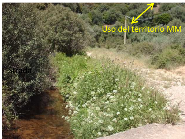
Struttura della sommità di sponda destra a macchia mediterranea (MM), con strada sulla sommità. Sponda risezionata.
