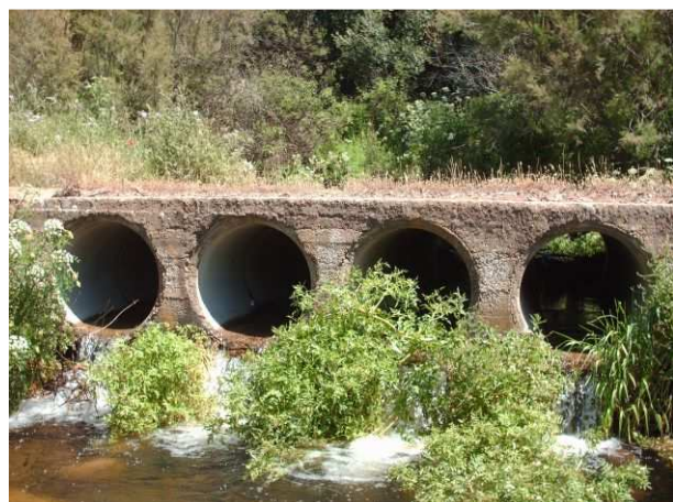
Culvert per attraversamento.
