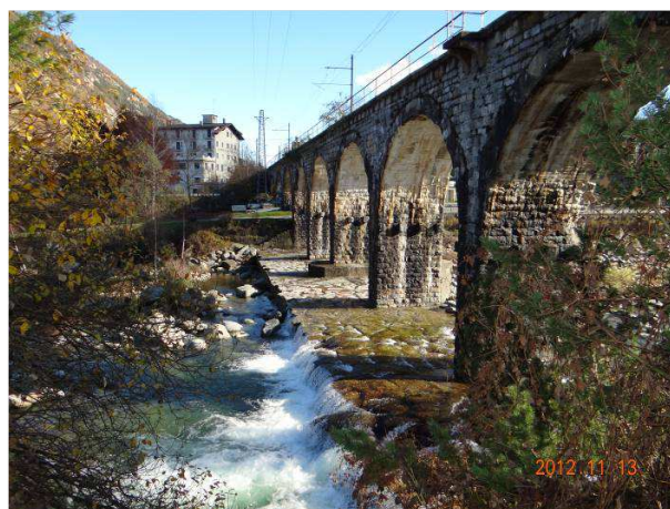
Il ponte della ferrovia nella parte bassa del tratto.
