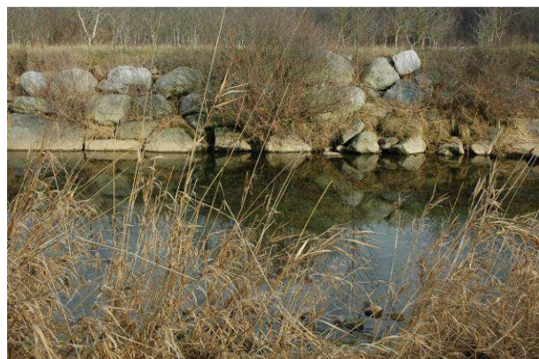
Difesa spondale in massi non cementati in sponda sinistra a valle di C. Bassa di La Cassa
