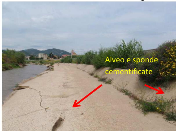
Alveo risezionato e rinforzato; sponda cementificata. Sponda artificiale a due stadi.
