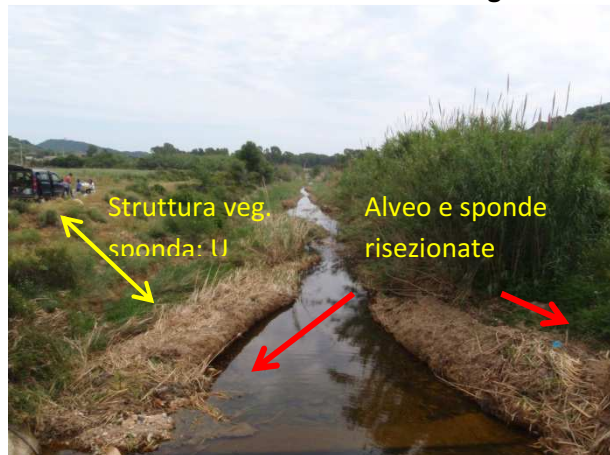
Alveo e sponda risezionati. Sponda artificiale a due stadi.
