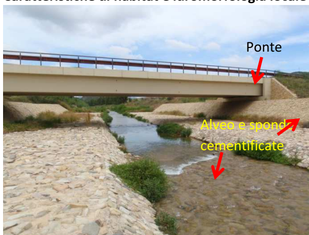
Alveo rettificato e cementificato. Ponte. Sponda cementificata.
