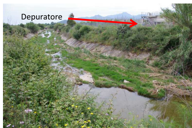
Alveo risezionato e sponda artificiale. Uso del territorio in sponda destra: depuratore.
