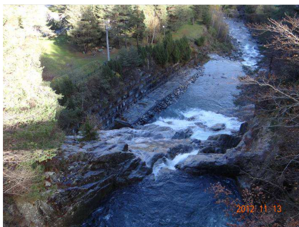
La parte iniziale del tratto 01SS2N282PI_5.
