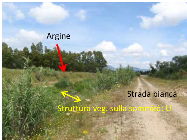
Struttura della sommità di sponda sinistra uniforme a vegetazione erbacea (U), con strada sulla sommità. Sponde arginate.
