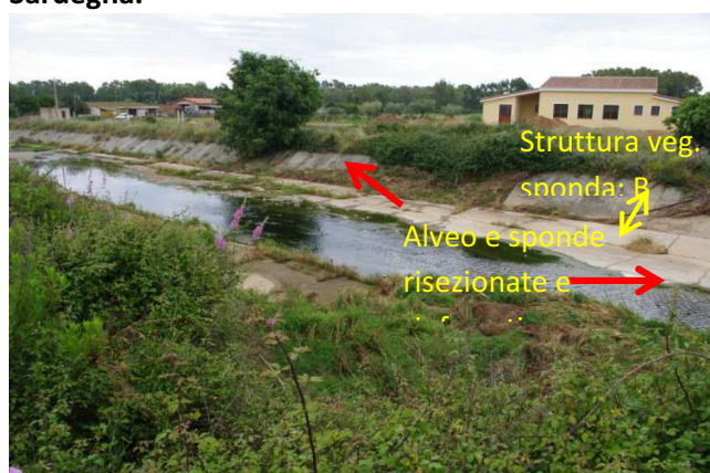
Alveo e sponda risezionati e rinforzati. Sponda artificiale a due stadi.
