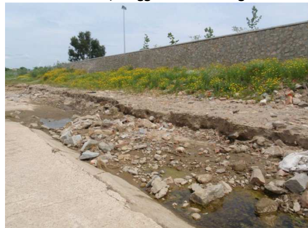
Alveo risezionato e rinforzato; sponda cementificata.
