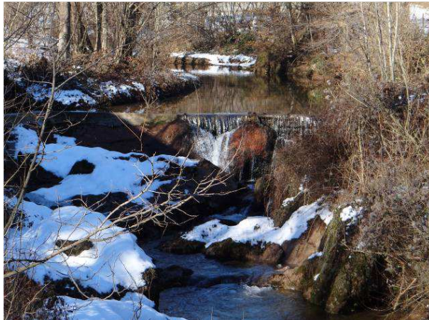
Opera di presa nei pressi di cascina Bastaroli.
