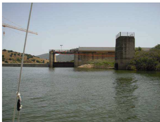
Lago Posada, diga e particolare paratoia
