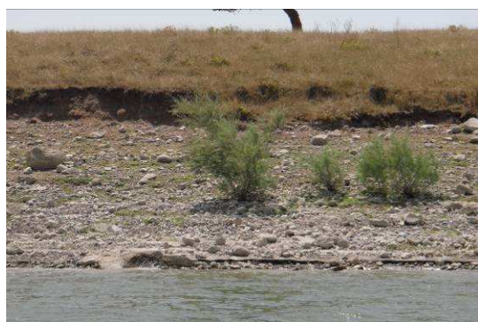
Lago Bidighinzu ed erosione spondale
