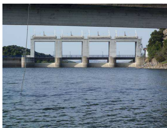
Lago Liscia, particolare: paratoie diga
