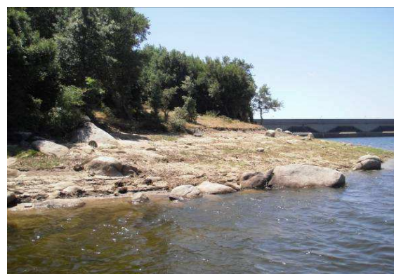
Lago Sos Canales, sponda e diga
