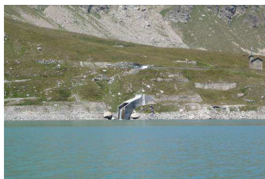
Lago Serrù e scarico
